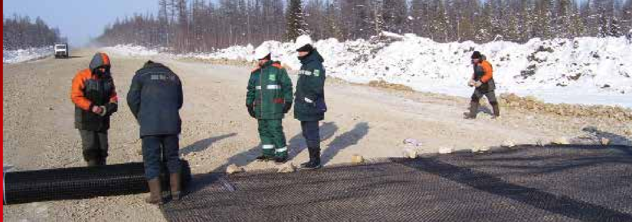
Реализация проекта в Западной Сибири: укладка георешетки Тенсар при температуре -40°C.
