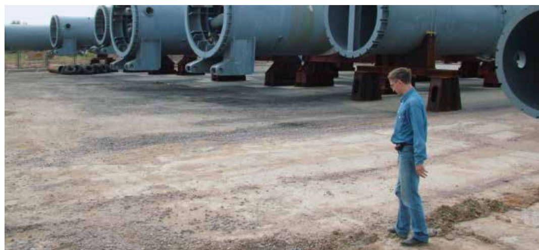
Массивные секции трубопровода временно установлены на площадке, армированной по технологии Тенсар®.
