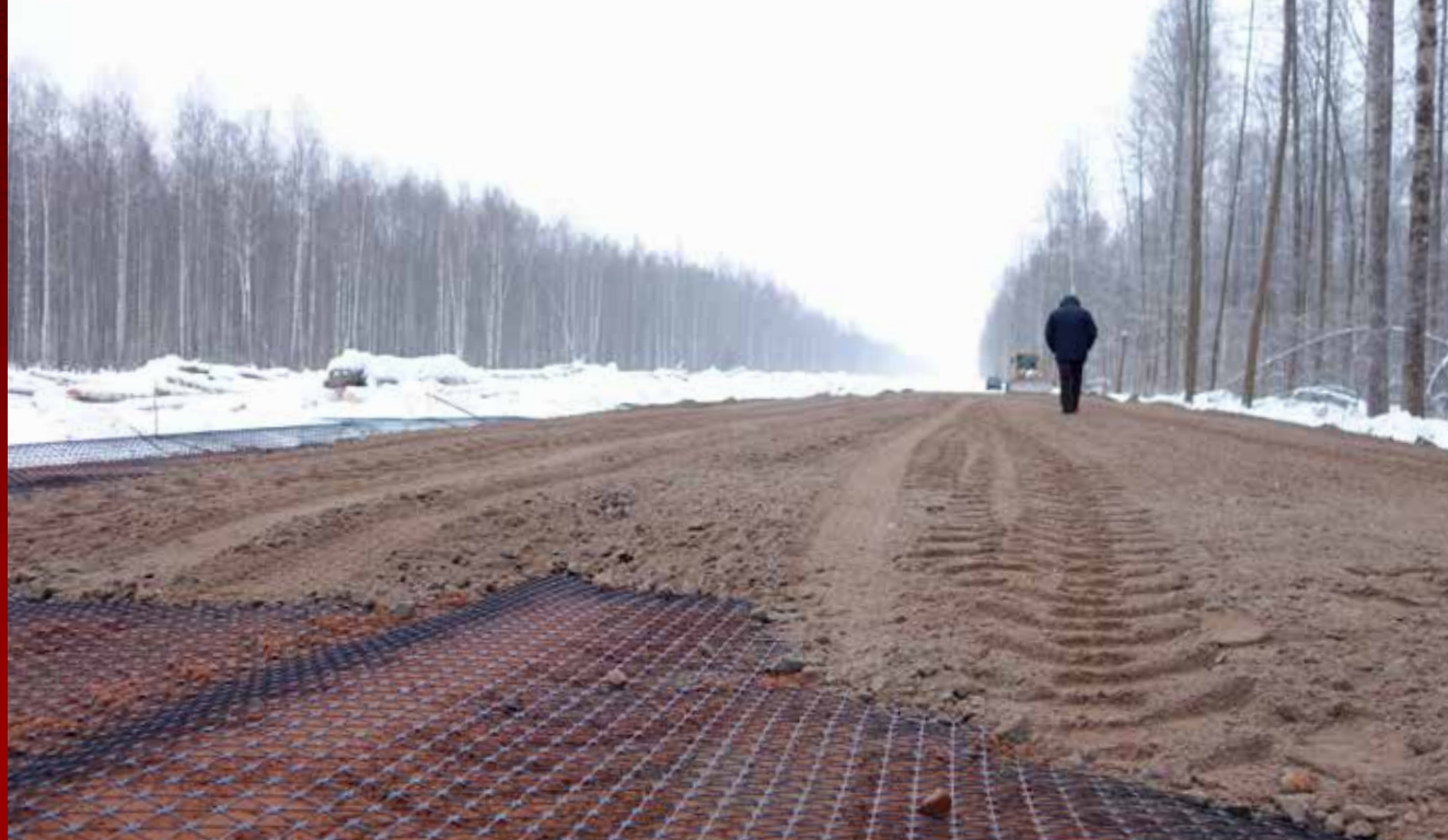
Укладка георешетки TriAx® для создания Механически Стабилизированного Слоя Тенсар
