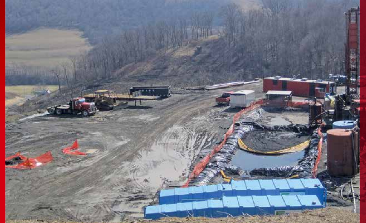
Использование георешетки TriAx® для создания безопасной рабочей площадки
