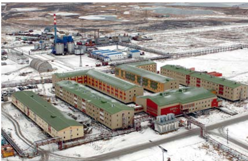
Вахтово-жилищный комплекс на Бованенковском месторождении
